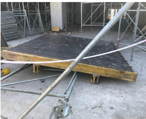
Situata pas rënies së kornizës mbajtëse duke u zhvendosur në pozicion të ri
