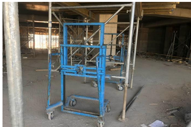
Pajisja e posaçme ngritëse / lëvizëse për ri-pozicionimin e kornizave mbajtëse
